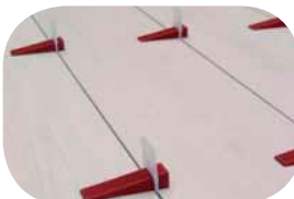
Ukázka zafixování a vyrovnaní velkoplošných keramických desek.
