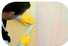
Vymezený podklad se napenetruje systémovou penetrační válečkou nebo malířskou štětkou.
