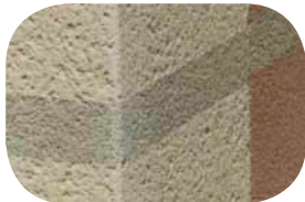
sejmutí matrice, možnost vložení kontrastní omítky do vybraných, maticí vytlačených, míst
