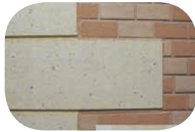
(alternativně může být povrch omítky ponechán bez škrábání tak jak vypadá po sejmutí matrice s vtlačeným kamínkem – vhodné na rohových a soklových partiiích)
