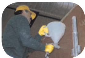
po uhlazení omítky nástřik jemného kameniva (např. živec) do ještě čerstvé omítky
