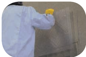
přiložení zvolené profilované matrice na takto připravenou omítku
