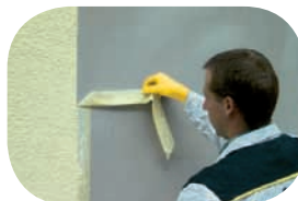
Místo změny odstínu nebo struktury omítky či nátěru v ploše se zalepí krepovou páskou.
