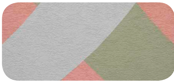
Místo změny odstínu nebo struktury omítky či nátěru v ploše se zalepí krepovou páskou.
