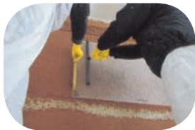
vtlačení matrice za pomoci válečků do povrchu omítky
